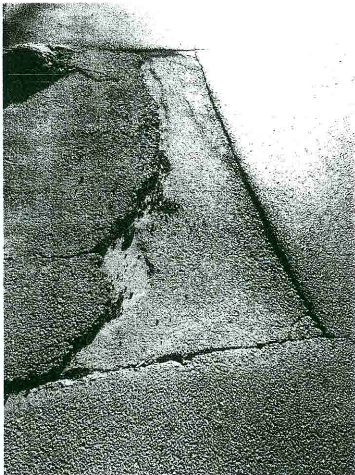
ul. Rakowicza – ubytki w jezdni, niewyregulowana wysokość studni
