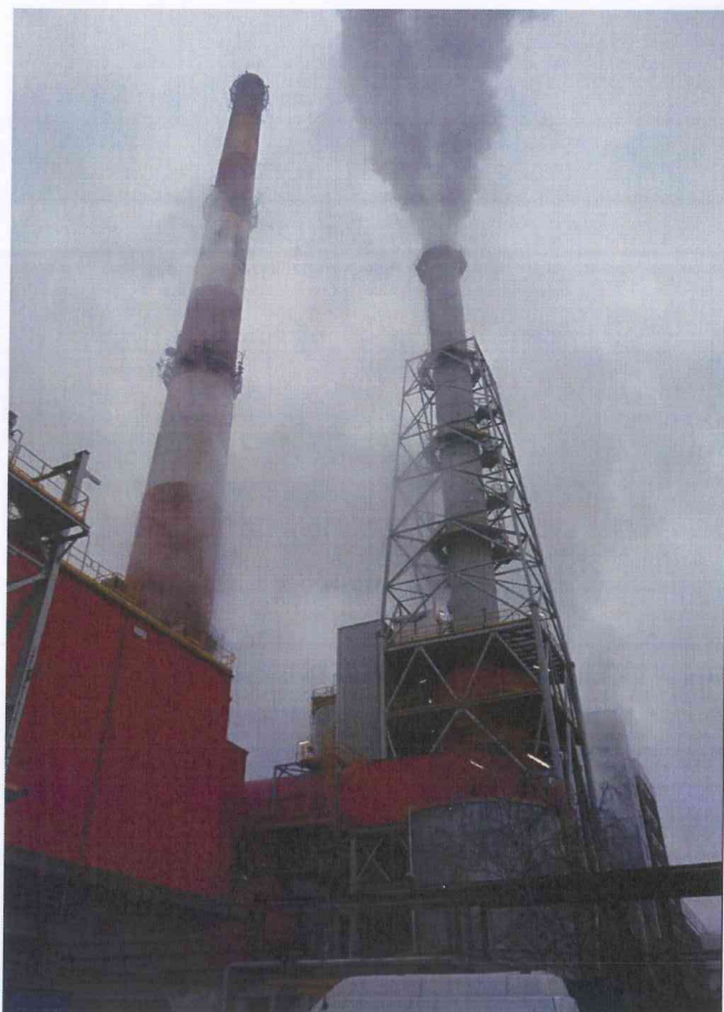
Zdjęcie nr 1 Ogólny widok stacji
