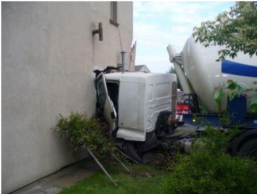
Zdjęcie 18 Zestaw samochód ciężarowy z naczepą do przewozu sypkiego wapna rozbił ścianę budynku mieszkalnego jednorodzinne. Fot. archiwum KP PSP w Inowrocławiu.
