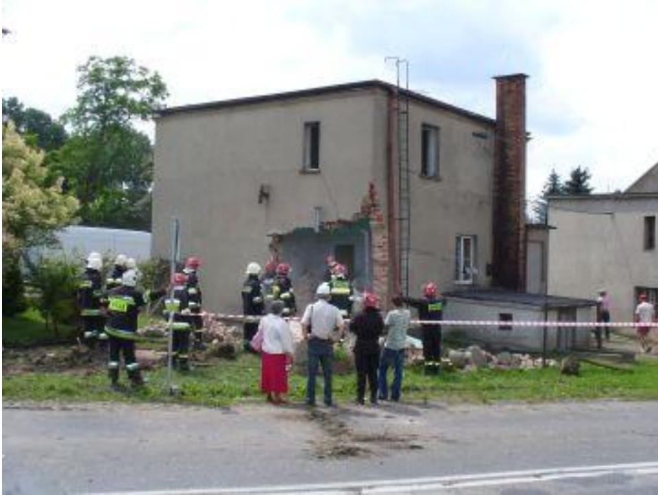
Zdjęcie 19 Strażacy usuwają gruz z zawalonej części budynku w asyście inspekcji nadzoru budowlanego. Fot. archiwum KP PSP w Inowrocławiu.
