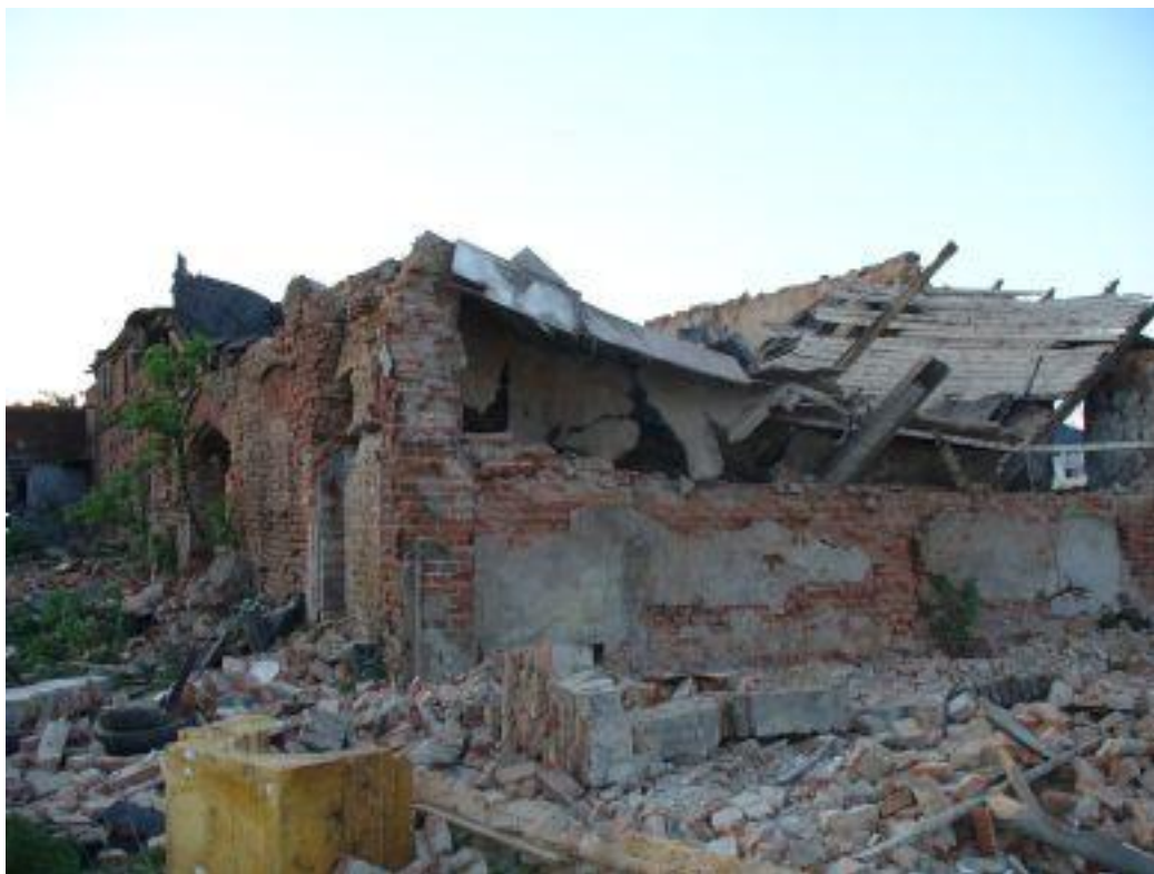
Zdjęcie 14 Zawalony budynek obory przy ul. Adama Znanińskiego w Inowrocławiu. Fot. archiwum KPPSP w Inowrocławiu.
