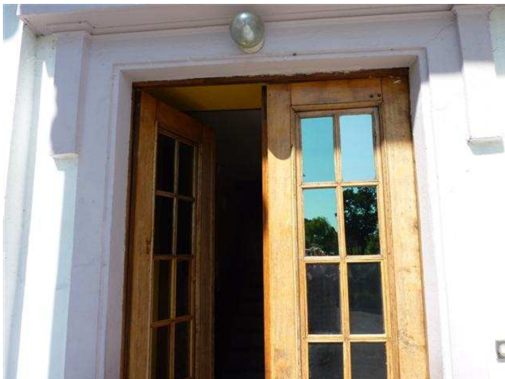
Fot. nr 3 – Szczegół drzwi I
