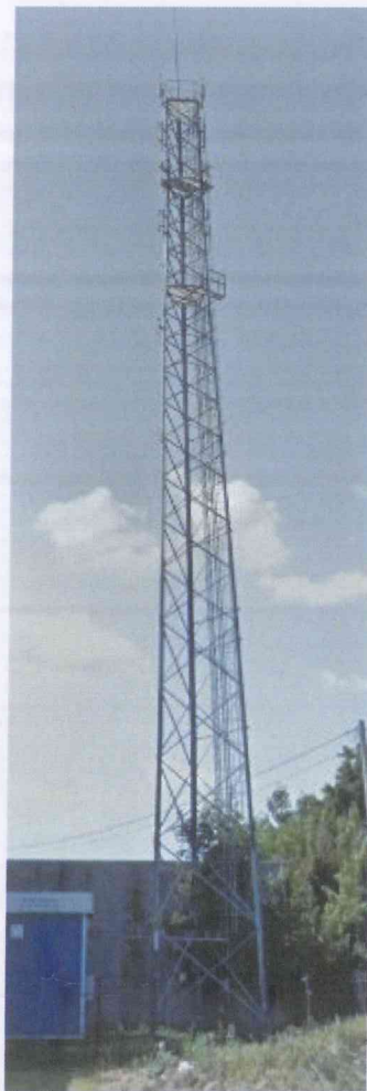
Fot. 1. SLR Sukowy – widok obiektu
