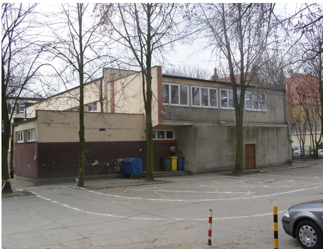
Fot. 4. SALA GIMNASTYCZNA OD TYŁU
