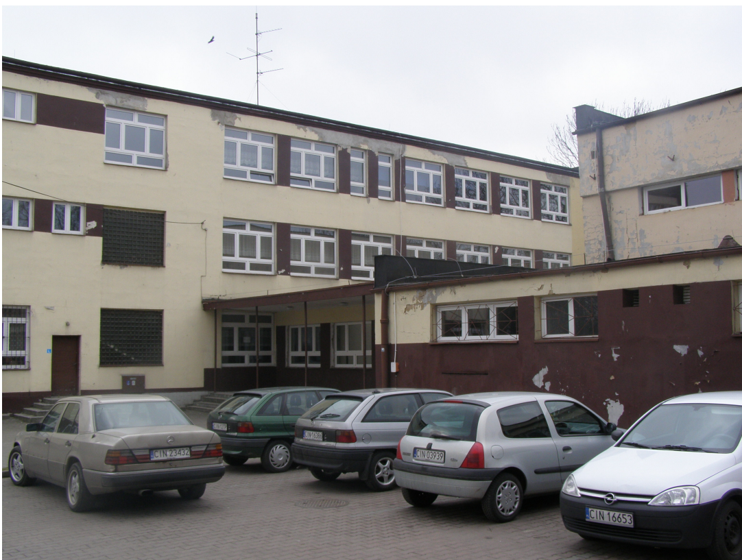
Fot. 2. BUDYNEK SZKOŁY OD STRONY PÓŁNOCNEJ
