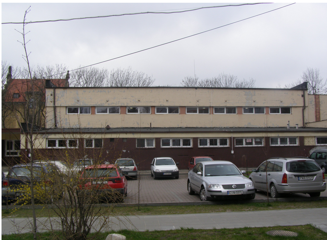
Fot. 3. SALA GIMNASTYCZNA OD STRONY DZIEDZIŃCA
