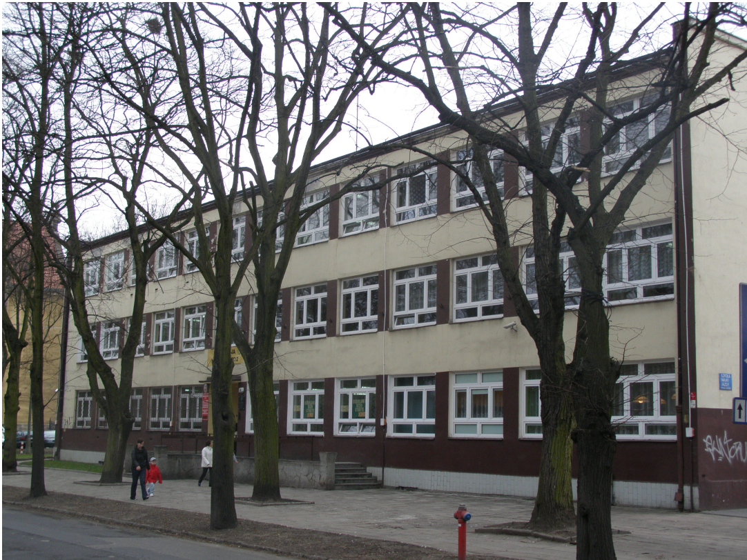
Fot. 1. BUDYNEK SZKOŁY - ELEWACJA POŁUDNIOWA (od ul. Narutowicza)
