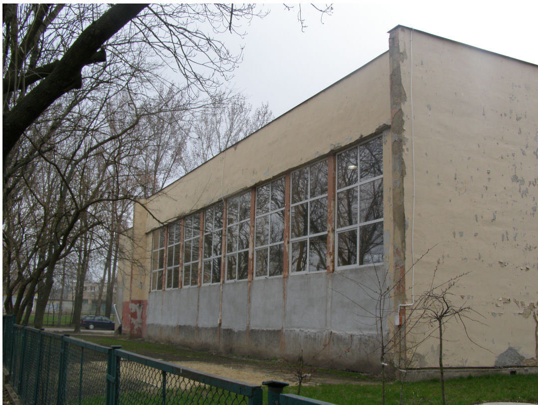
Fot. 5. SALA GIMNASTYCZNA OD STRONY WSCHODNIEJ
