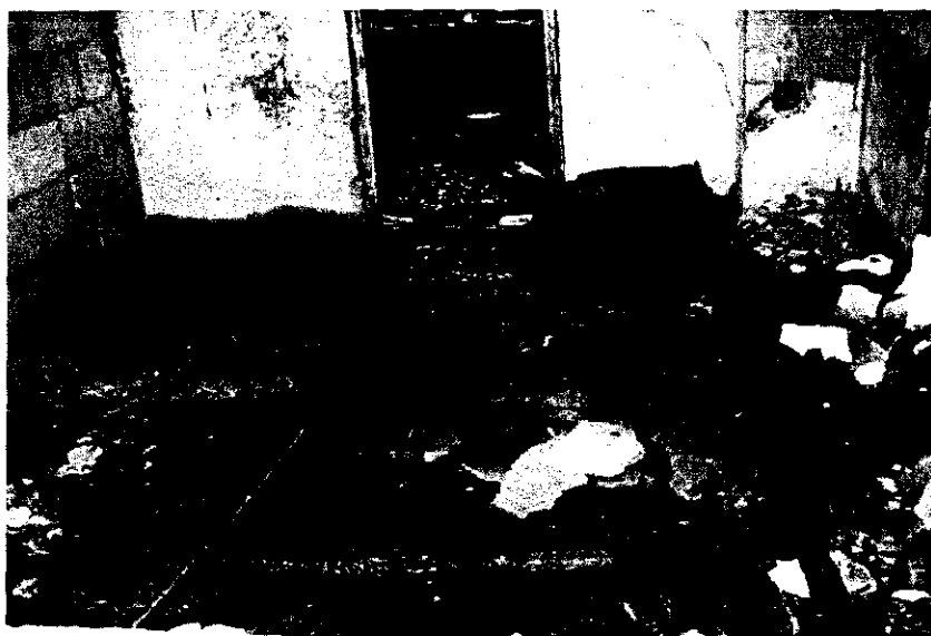
Zdjęcie 8. Wypalone wnętrze budynku mieszkalnego jednorodzinnego w m. Ściborze.
